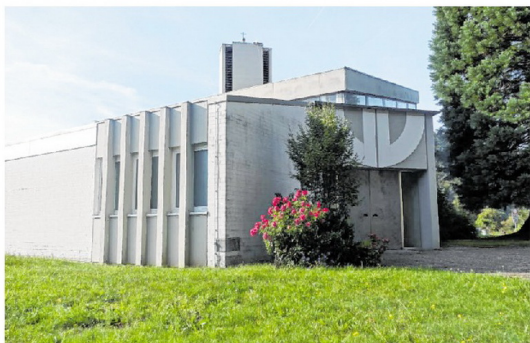
Die Kirche Grünenwört ist eine der wenigen Kirchen, die der roten Kategorie zugeordnet wurden. Das Gebäude soll künftig mit alternativen Konzepten finanziert werden.
