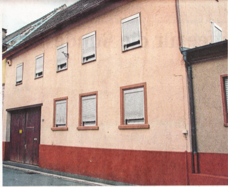
In diesem Gebäude im Hauptring in Höhefeld können ab sofort bis zu sechs Geflüchtete untergebracht werden. In der Sitzung des Ortschaftsrates wurden die Bürger informiert.
