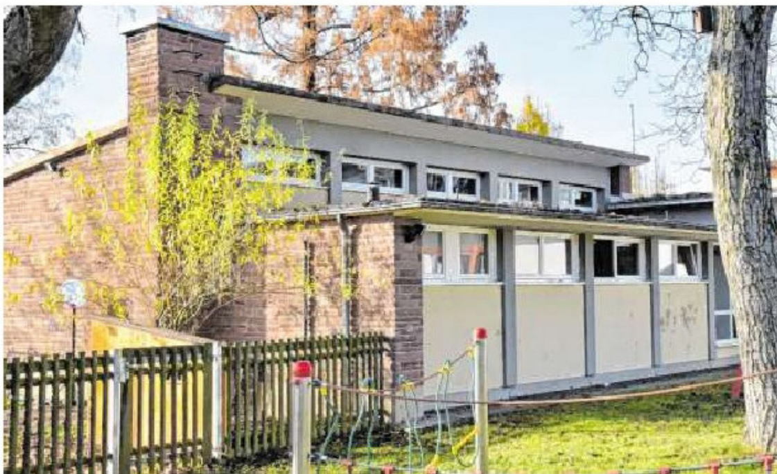
Der evangelische Kindergarten in Höhefeld wird generalsaniert und erweitert, um bauliche und pädagogische Anforderungen zu erfüllen.
